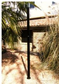
**Barriera SLIM monofacciale 2 mt ; COPPIA Barriera ad infrarossi attiva con 4 raggi in colonna SLIM da 2 metri;** Installazione: in esterno a pavimento; **Portata massima: 60 metri;** Colonna già precablata in fabbrica solo da collegare alla centrale allarme; funziona in AND e OR; Completa di sistema di termostatazione (24V), tamper antiapertura e tutto il necessario per l'installazione a pavimento; **Diametro della colonna: Ø 72 mm.**
